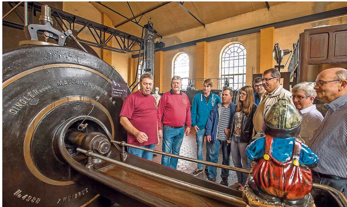
Norbert Wagner und Werner Hektor (hinten, von links) erklären Besuchern die Velsener Dampffördermaschine. 1916 gebaut, steht sie heute unter Denkmalschutz. Funktionsfähig ist sie immer noch. FOTO: JENAL
